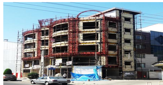
شکل ۵۰. مجتمع در حال ساخت و ساز در گلسار
